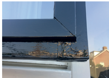
Verouderd raam. (scheur, kans op terugkeer)
